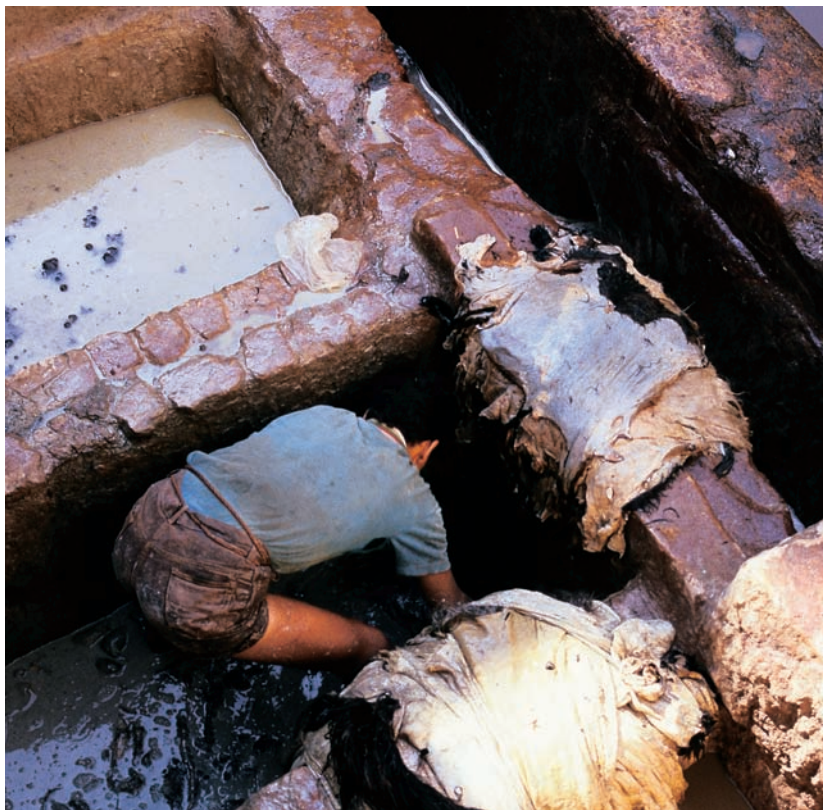
Acima: manutenção de esgotos em Bamaco (Mali).
